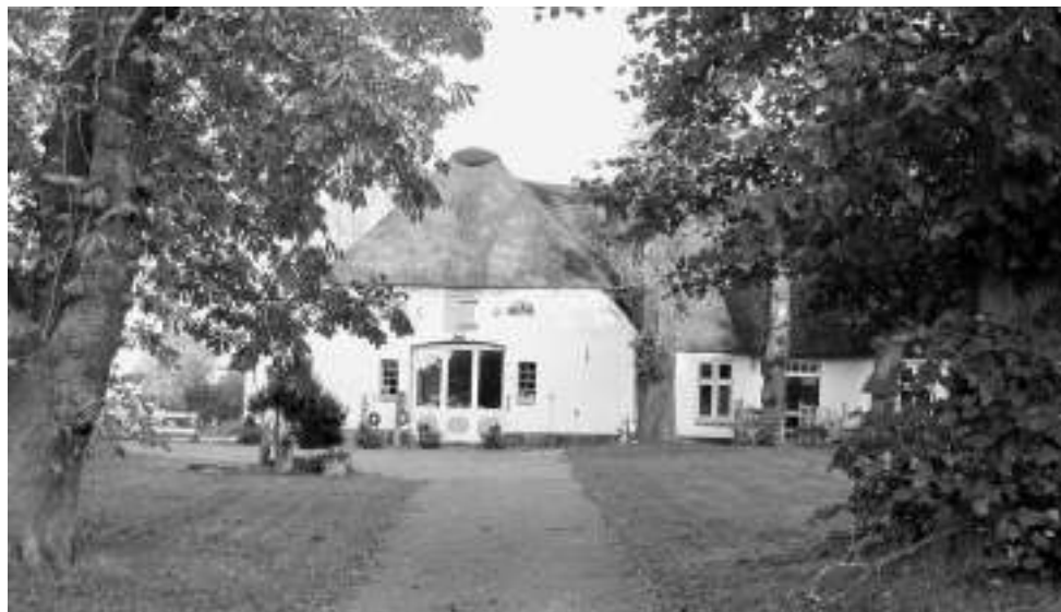
Das Haus vor der Sanierung (Foto: Chronikgruppe Norderstapel)
