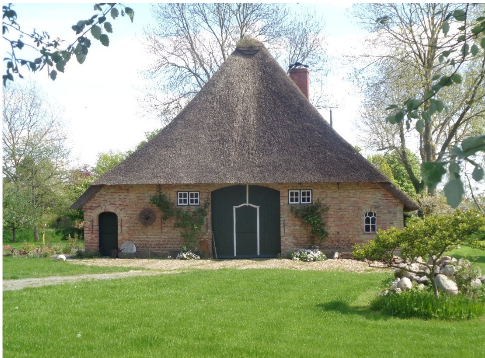
Das Haus Deichweg 8 in Drage (Foto: Arno Vorpahl, 2026)
