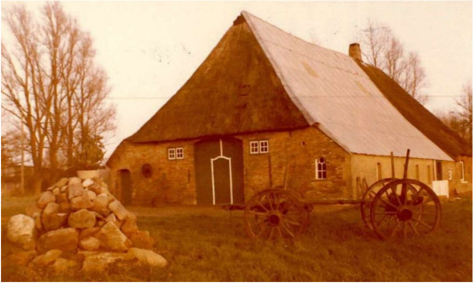
Vor der Instandsetzung war ein Teil des Daches mit Wellblech gedeckt (Foto: Leo Popien / Sammlung C+J Eichmann)
