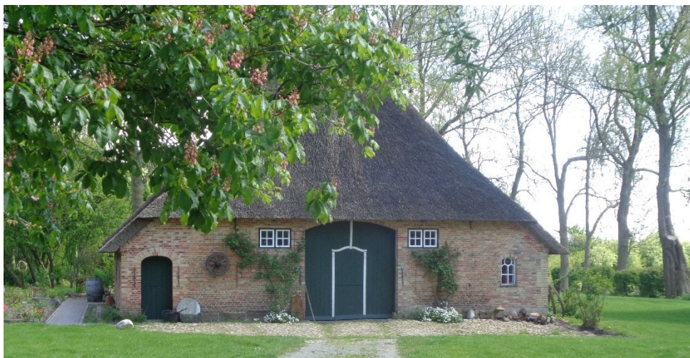
Das Haus Deichweg 8 in Drage (Foto: Arno Vorpahl, 2026)
