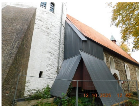
Verbauung der SW-Ecke des Langhauses
