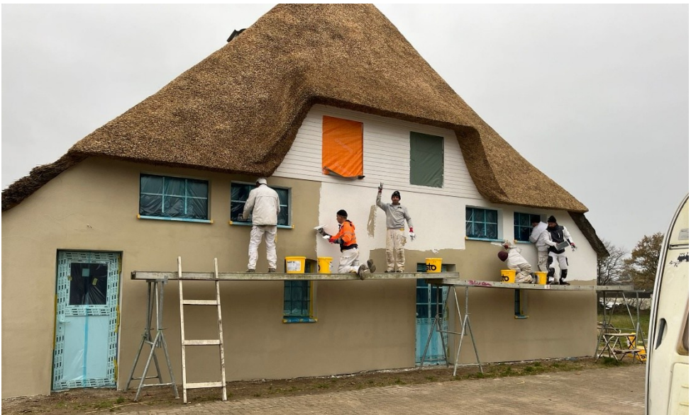
Außenputzarbeiten an der neuen Reetdachfront mit Fenstern
